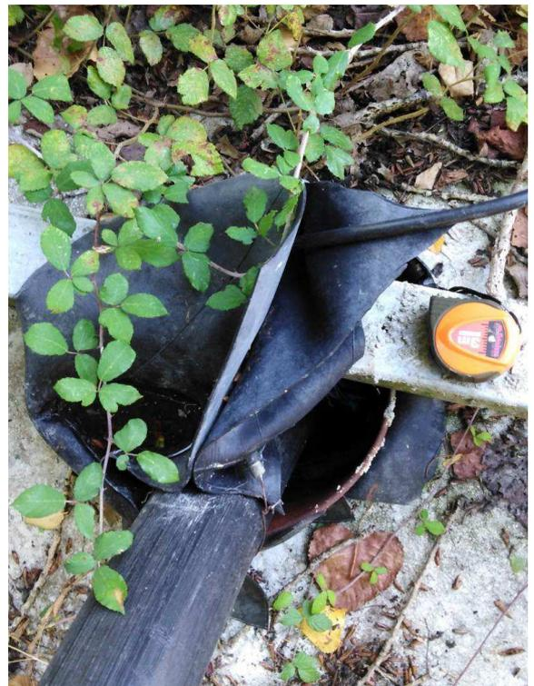
Photographie n° 12 : forage au sein du BAC, en bordure de champs et de chemin, possédant une margelle bétonnée, sans capot de fermeture et avec une hauteur de dépassement de la tête insuffisante
