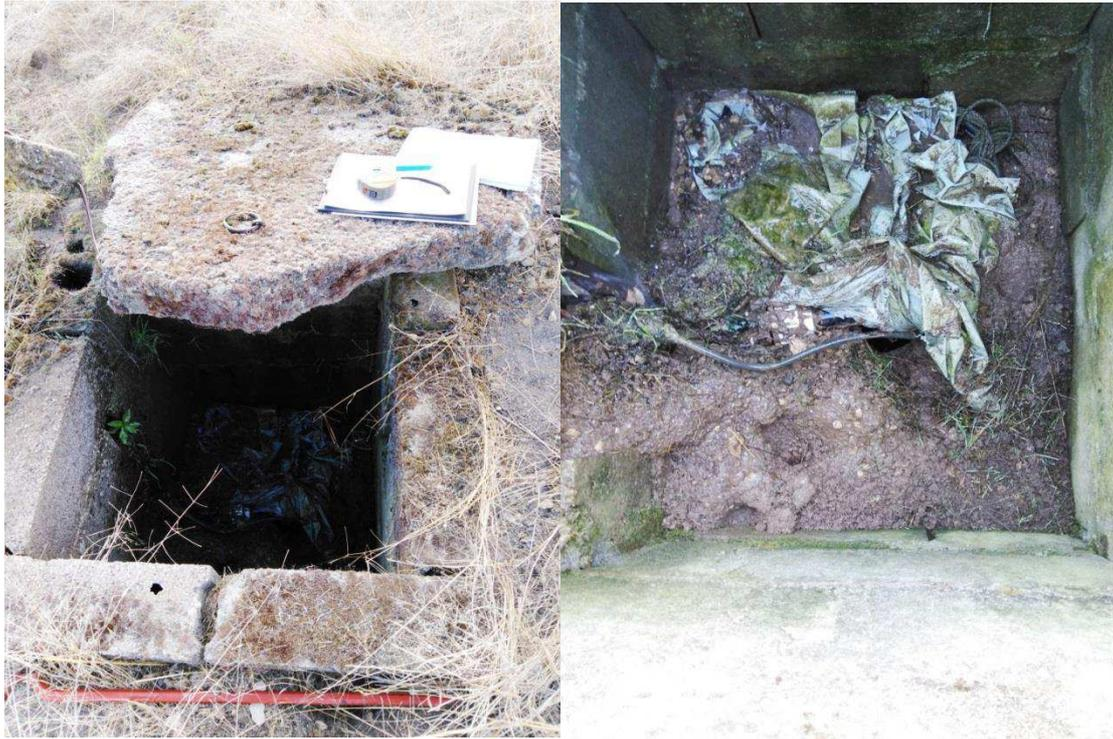
Photographie n° 11 : forage au milieu d'un champ dont la tête de forage se trouve en contrebas dans un regard d'un mètre de profondeur ferme par une dalle béton incomplète
