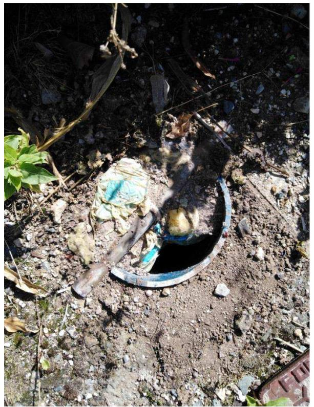
Photographie n° 10 : forage domestique situé en bordure de chemin dont la tête ne dépasse pas du sol et est recouverte par une plaque en fonte.
