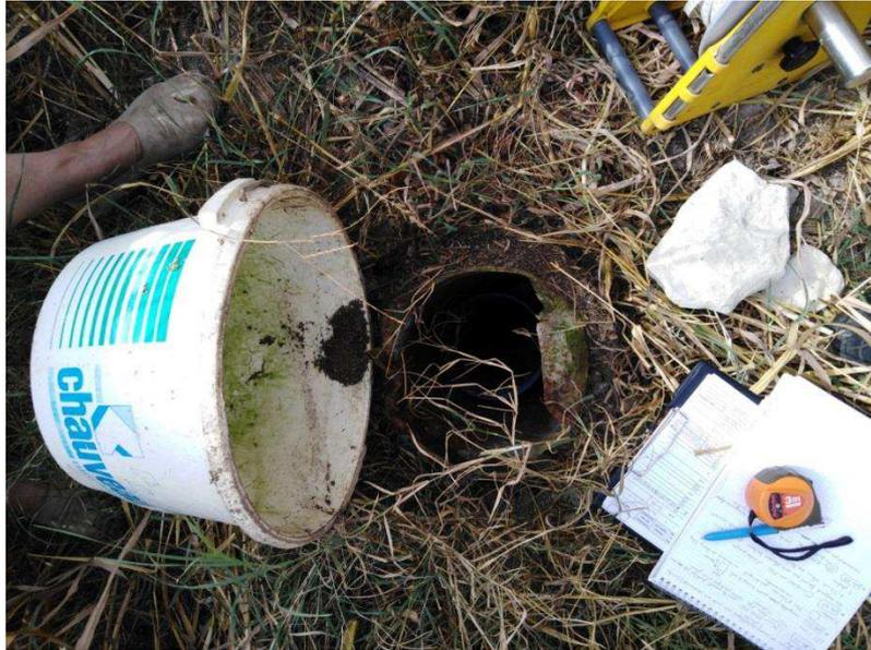
Photographie n° 13 : forage inutilisé avec une tête non conforme
